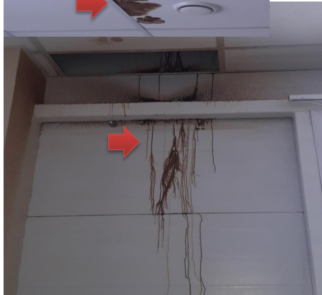
Протечки потолка
