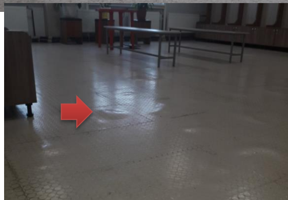
Вздутие покрытия пола из линолеума
