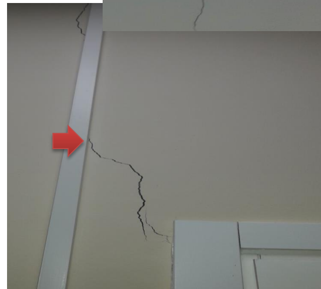
Трещины в штукатурке стен
