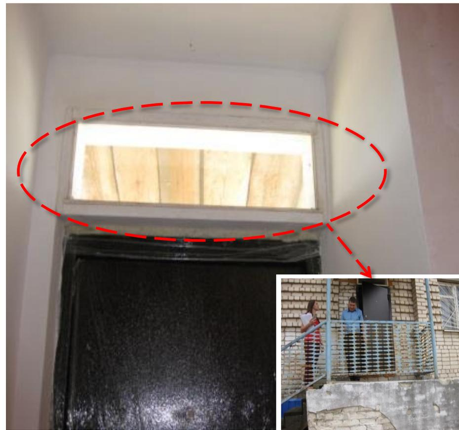
**Две квартиры не соответствуют требованиям по естественному освещению – функцию окна на кухне выполняет стеклянный элемент над входной дверью**
