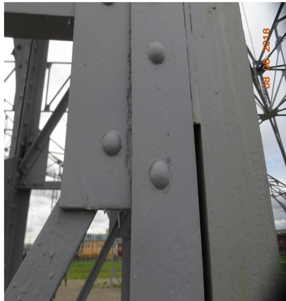
**После гидроабразивной очистки металлических конструкций (пакгаузов) остались участки с неудаленной ржавчиной.**
