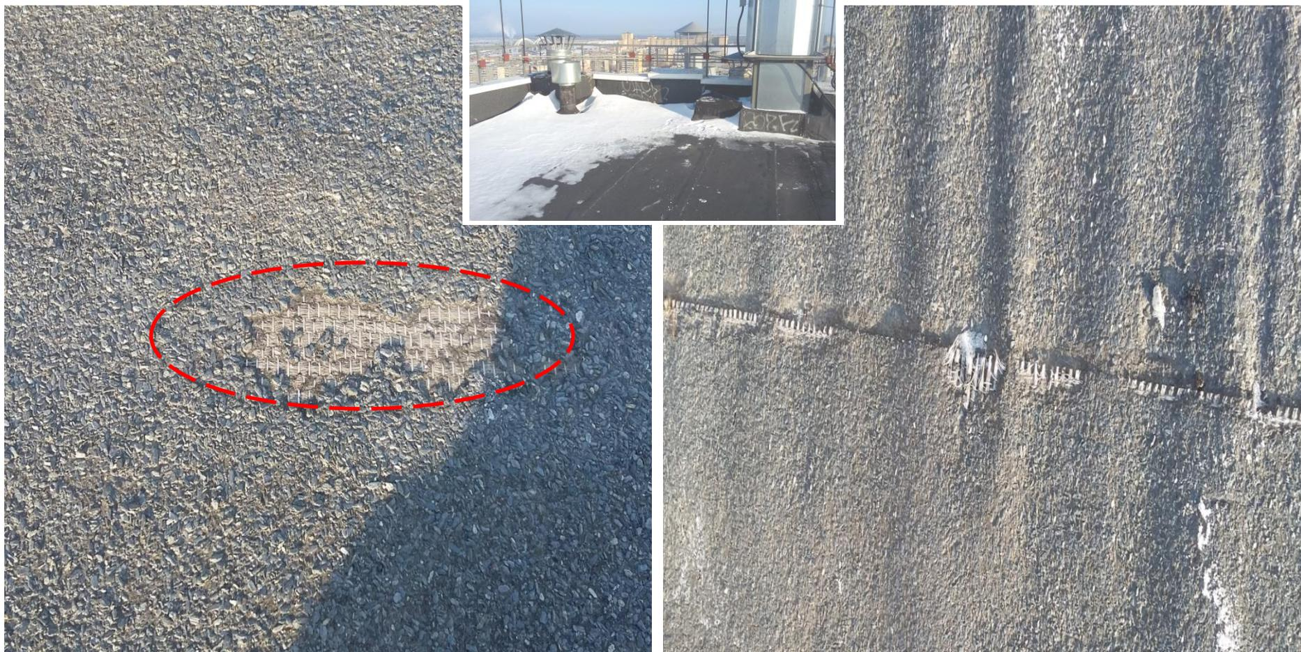
**Кровля (тип-А). Кровельный материал имеет признаки износа: трещины, вздутие, исчезновение защитного гравийного слоя (местами), высыхивание и потертости. Невыполненные работы по смене кровельного материала в акты включены и оплачены.**
